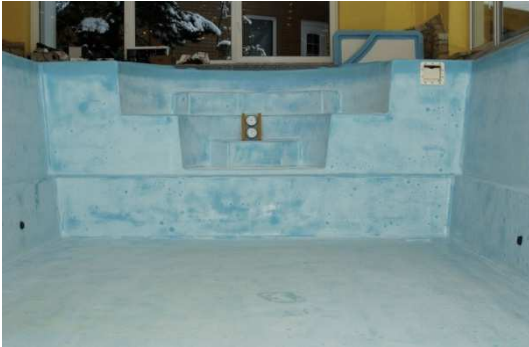
zu sanierendes Becken
